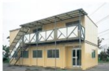
連棟ユニットハウス 5連棟の設置で
